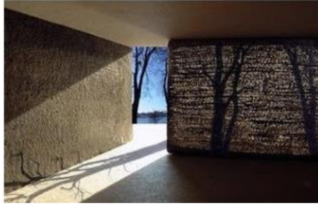
الصورة رقم (11) تبين الخرسانة الشفافة في الجدران الخارجية
