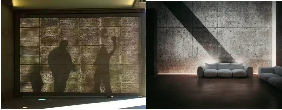
الصورة رقم (6) تبين جدار مصنوع من الخرسانة الشفافة
