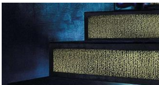
الصورة رقم (9) تبين الخرسانة الشفافة في السلالم بإضاءة من الأسفل
