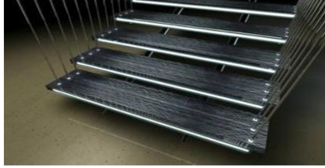
الصورة رقم (10) تبين الخرسانة الشفافة في السلالم مع مصابيح LED
