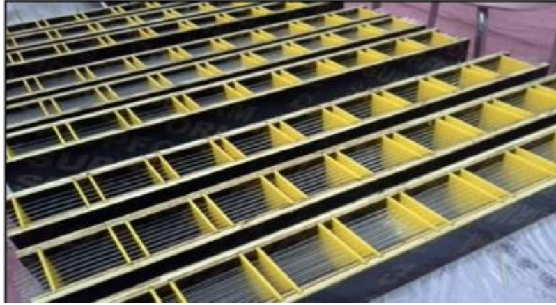
الصورة رقم (3) تبين القوالب الخشبية بعد تثبيت الألياف الخشبية
