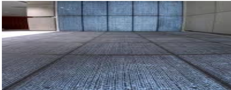
الصورة رقم (7) تبين الخرسانة الشفافة في الأرضيات
